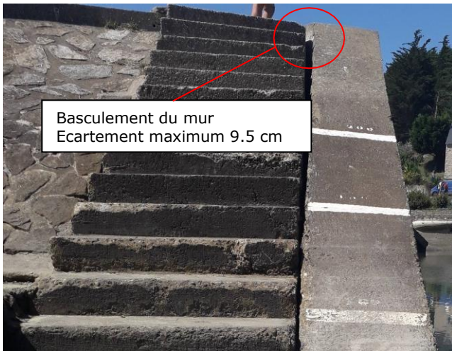
Fissure en arrière du mur - Photos 2019 et 2020
