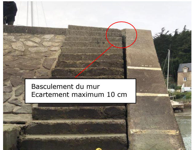
Fissure en arrière du mur - Photos 2019 et 2020
