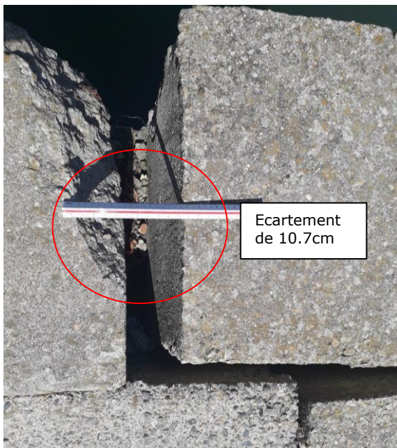
Fissure au niveau de la longrine- Photos 2019 et 2020
