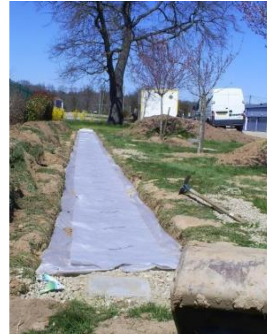
Fermeture du géotextile
