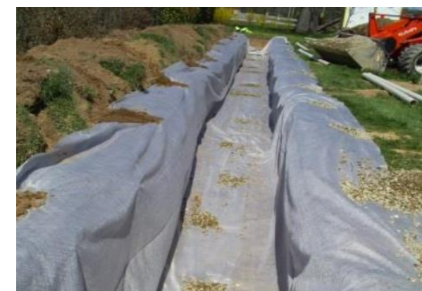
Mise en place du géotextile
