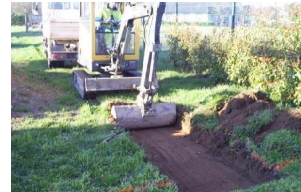
Décapage de la terre végétale
