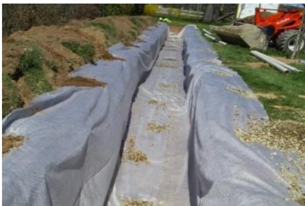
Mise en place du géotextile
