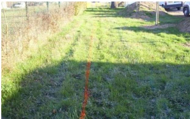
Marquage au sol
