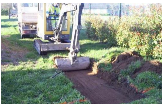
Décapage de la terre végétale
