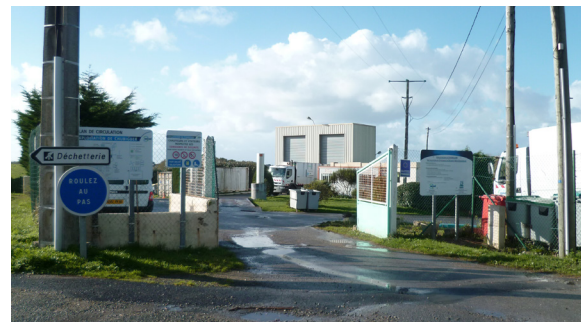
- Entrée du site ISDND -
