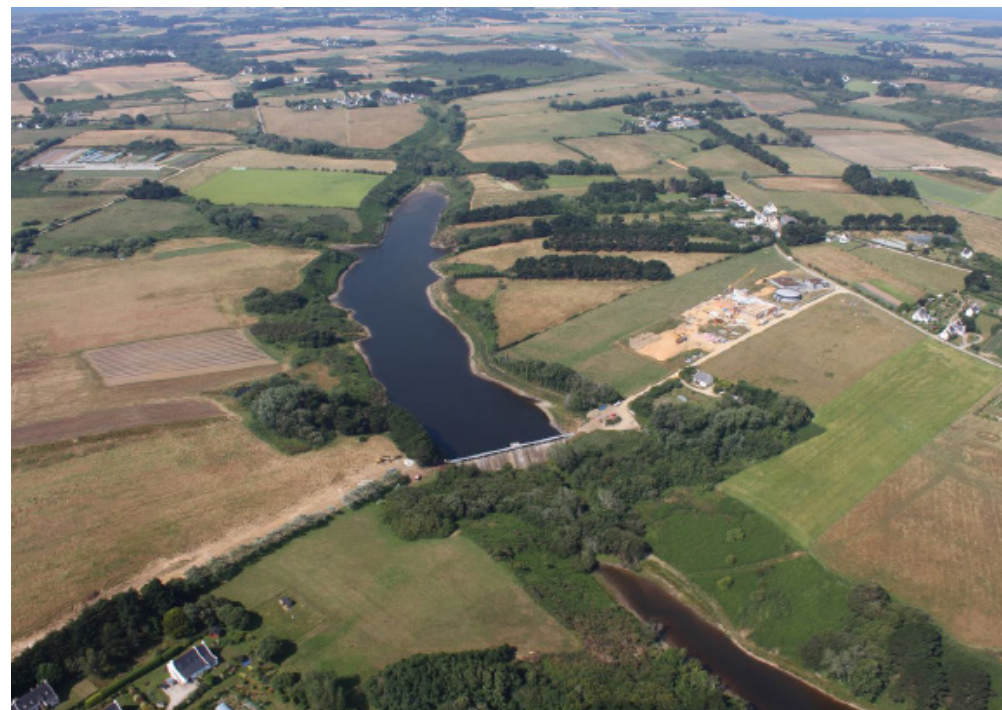
Barrage et usine d'eau d'Antoureau, vue du ciel
